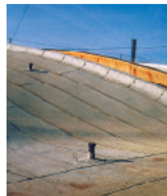
10. A hőszigetelő táblákat forrólevegős hegesztéssel rögzített APP modifikált bitumenes lemez sávokkal erősítették meg
