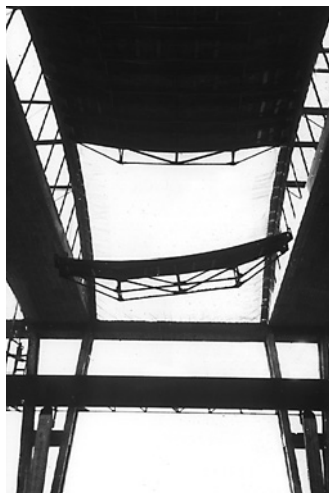
4-5. Az építéstechnológia elvi ábrája és fotója: héjfelület zsaluzata két elkészült ívpár közé
